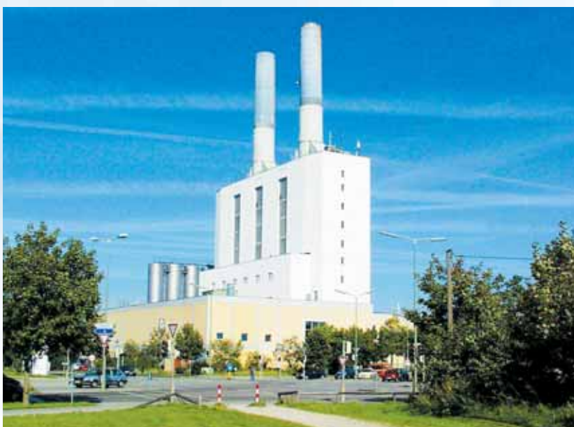
Das HKW Sendling ist heute eine Fernwärme-Verteilstation.
