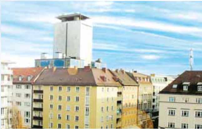
Das Heizwerk Theresienstraße.
