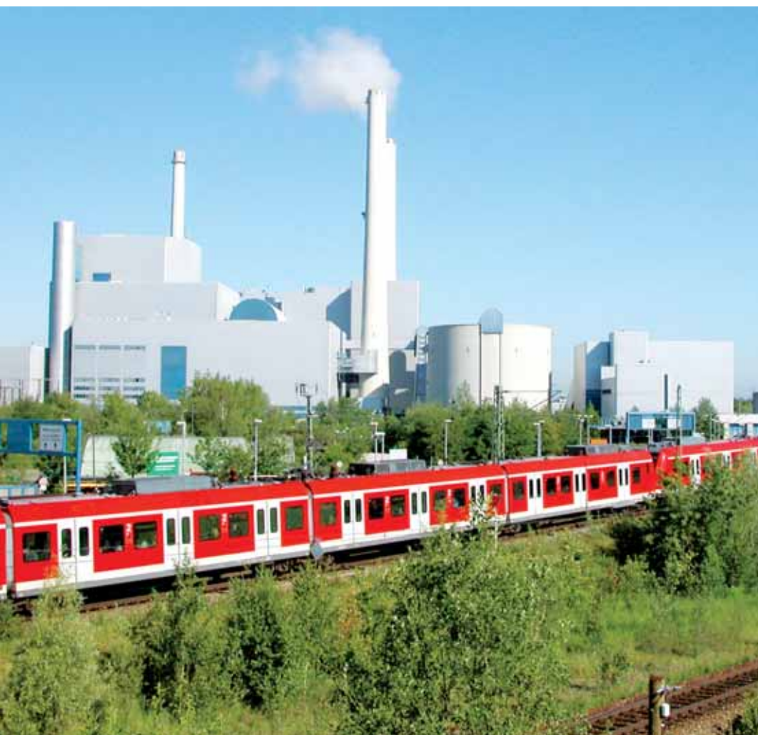
Blick von Nordosten auf das Heizkraftwerk Nord.
