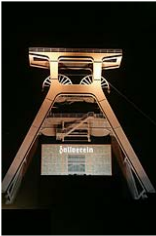
Abb. 6: Fördererturm der Zeche Zollverein XII 49
