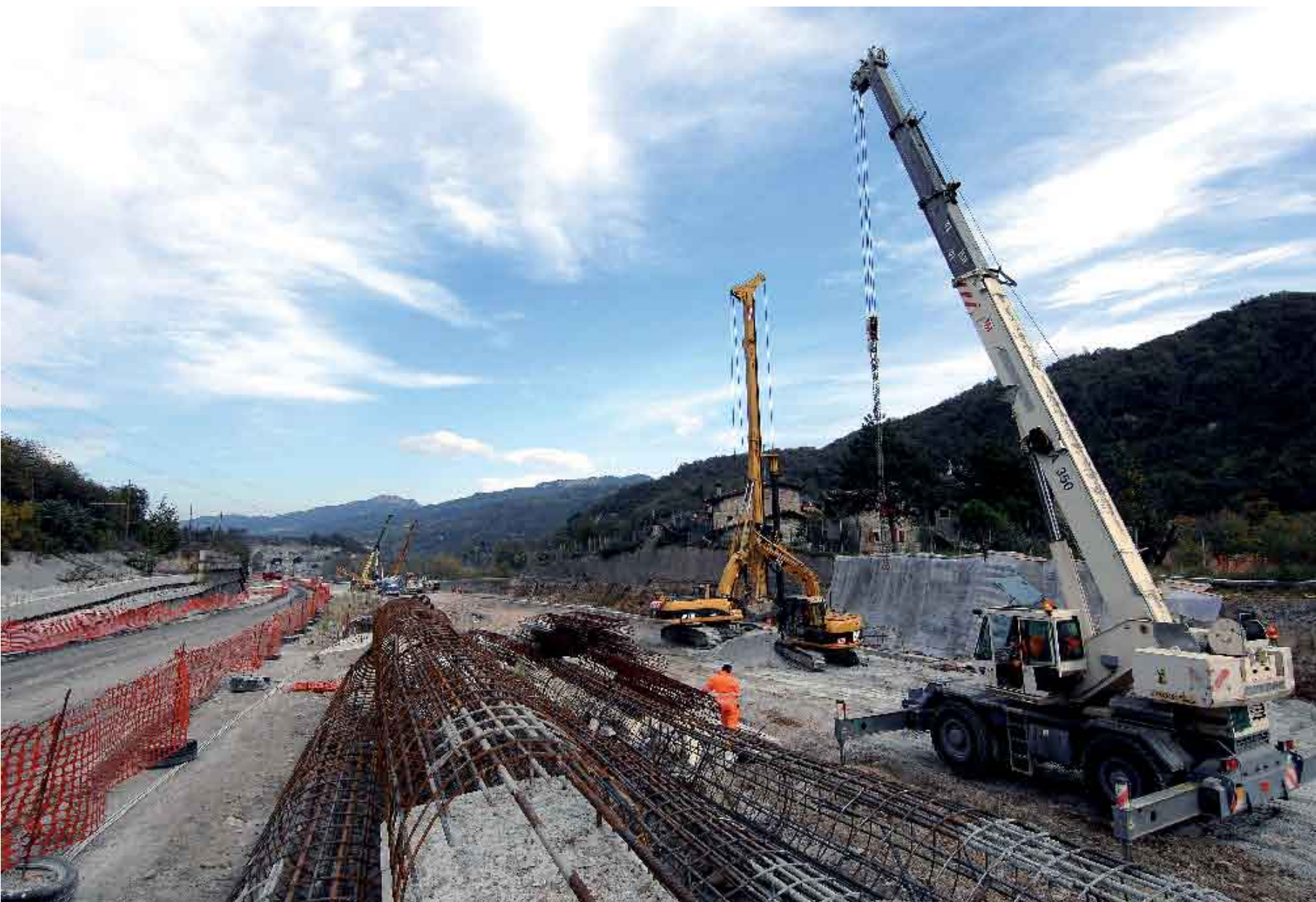
Ottobre 2006 Lavori per il potenziamento dell'A1 nel tratto Bologna-Firenze, tra Sasso Marconi e La Quercia.
