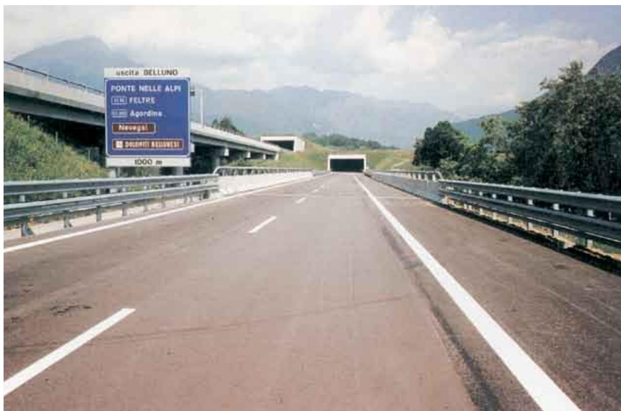
L'Autostrada A27 Mestre-Belluno in costruzione nei pressi della Barriera di Ponte nelle Alpi. Anche l'A27 viene completata nel 1995.
