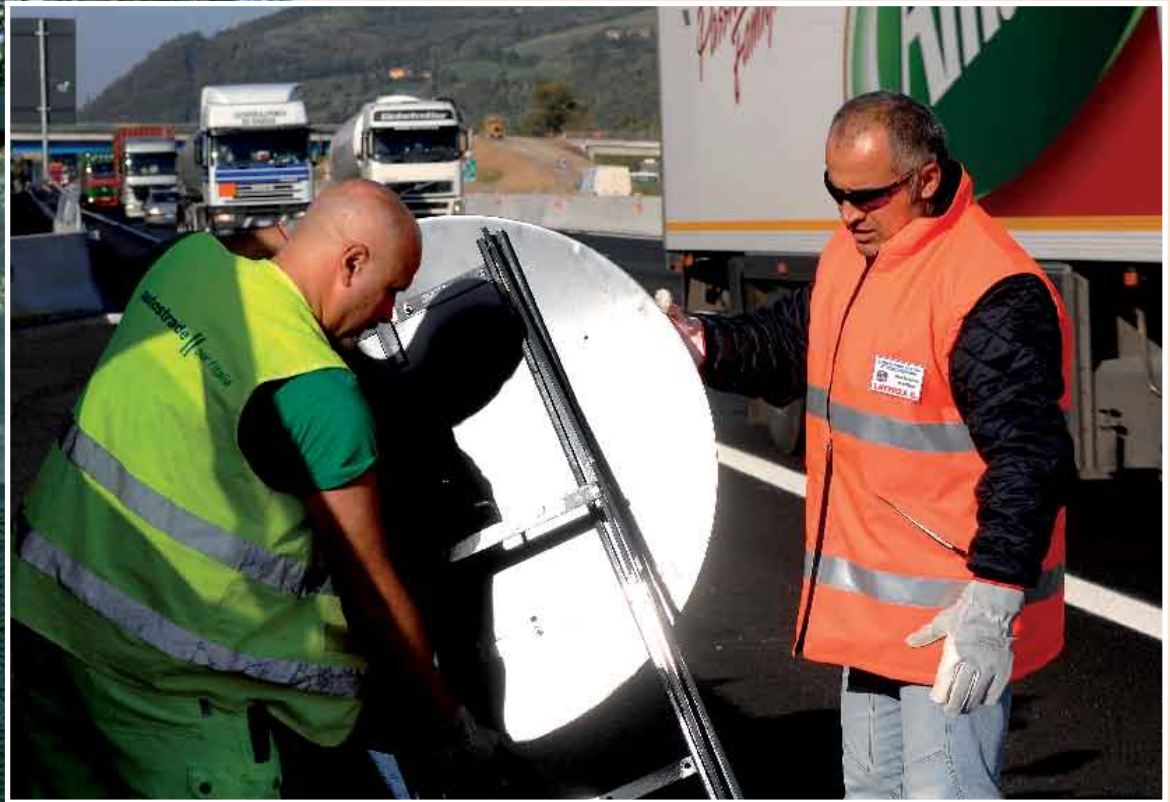
Installazione di barriere antirumore e di segnaletica per lavori sull'Autostrada del Sole nei pressi di Bologna.
