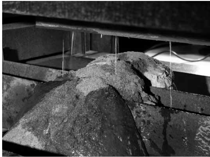
Abb. 24 Alte ›Schleifmühle‹ in Schwerin. Während das Schleifmittel von Hand aufgestreut wird, rinnt das Wasser aus einer kleinen Leitung auf die Schnittstelle.
