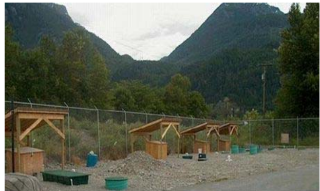
Mamquam Test Facility
