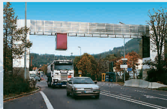
⑥ Schmid Peoplemover® nach dem Aufbau. Referenzanlage in Pfullingen (B 312, Marktstraße) bei Stuttgart.
