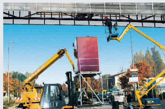
⑤ Einsetzen der Aufzugskabine
