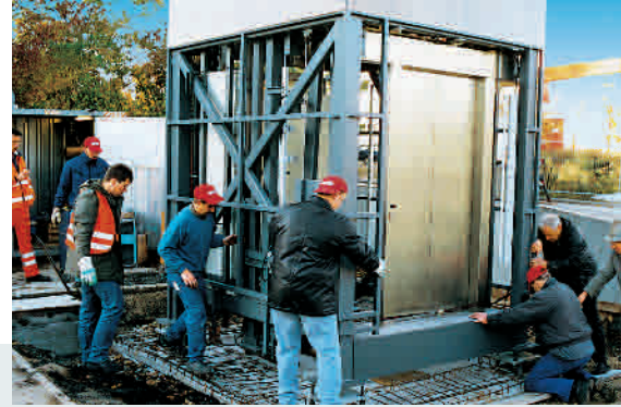
③ Befestigung der Fundamente
