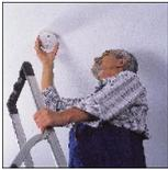
Rauchmelder lassen sich - auch ohne handwerkliches Geschick - mit wenigen Handgriffen montieren. Rauchmelder müssen in waagrechter Lage an der Decke montiert werden. Wenn immer möglich sollte eine Position in der Mitte des Raumes gewählt werden. Aufgrund des Verhaltens von Rauch (Luftpolsterung) darf ein Rauchmelder nicht an den Deckenränder oder in den Deckenecken montiert werden.
