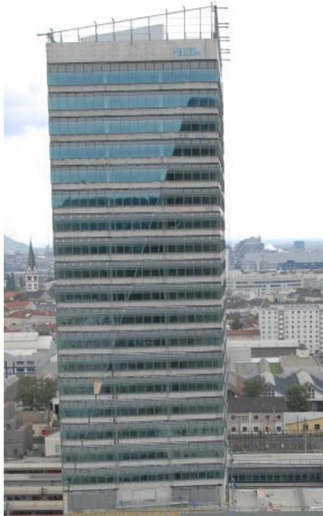
Der Power Tower der ENERGIE AG besitzt eine Glasfassade mit Photovoltaikelementen zur Stromerzeugung. (Fotos: KOMM)
