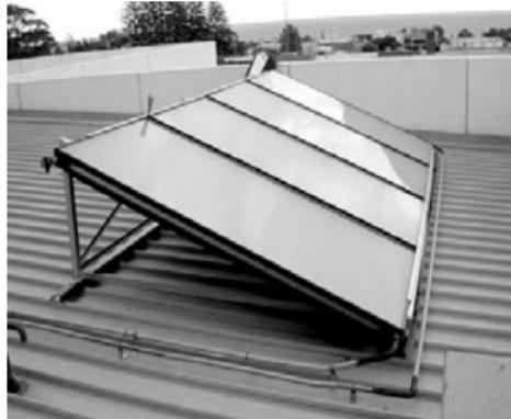
njih. Zagrijana voda se zatim odvodi u spremnik gdje se energija akumulira. Ako se solarni sustav nalazi u podneblju gdje zimi temperature padaju ispod 0°C, umjesto vode kroz kolektore prolazi mješavina sa sredstvom protiv smrzavanja. Zatim se ta mješavina odvodi u spremnik gdje pomoću izmjenjivača topline predaje energiju vodi unutar spremnika. Ohlađena mješavina se pumpa nazad u kolektor gdje se ponovo zagrijava.
