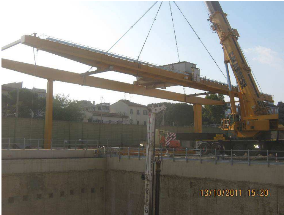
FOTO 6 – Allestimento del carroponete a servizio del Pozzo lancio frese
