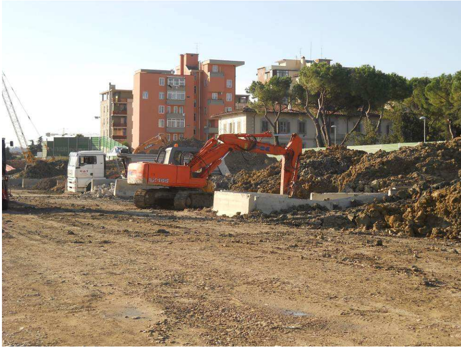
Foto 4: movimentazione e conferimento a discarica terre di scavo diaframmi
