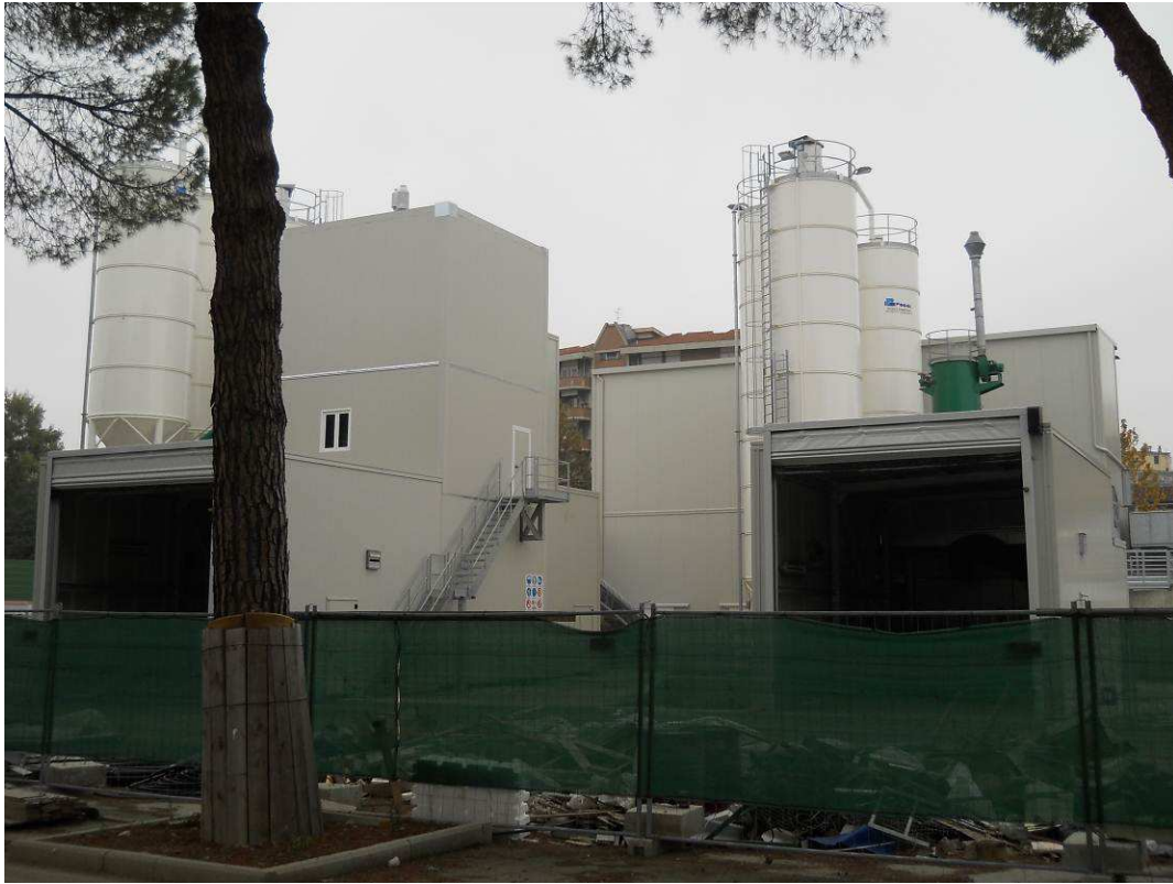
Foto 2: allestimento centrale betonaggio
