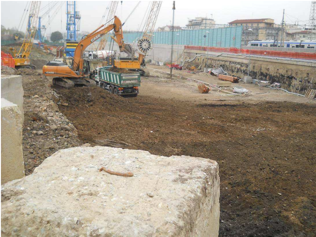
Foto 3: movimentazione terre per spostamento rampa di cantiere lato BELFIORE
