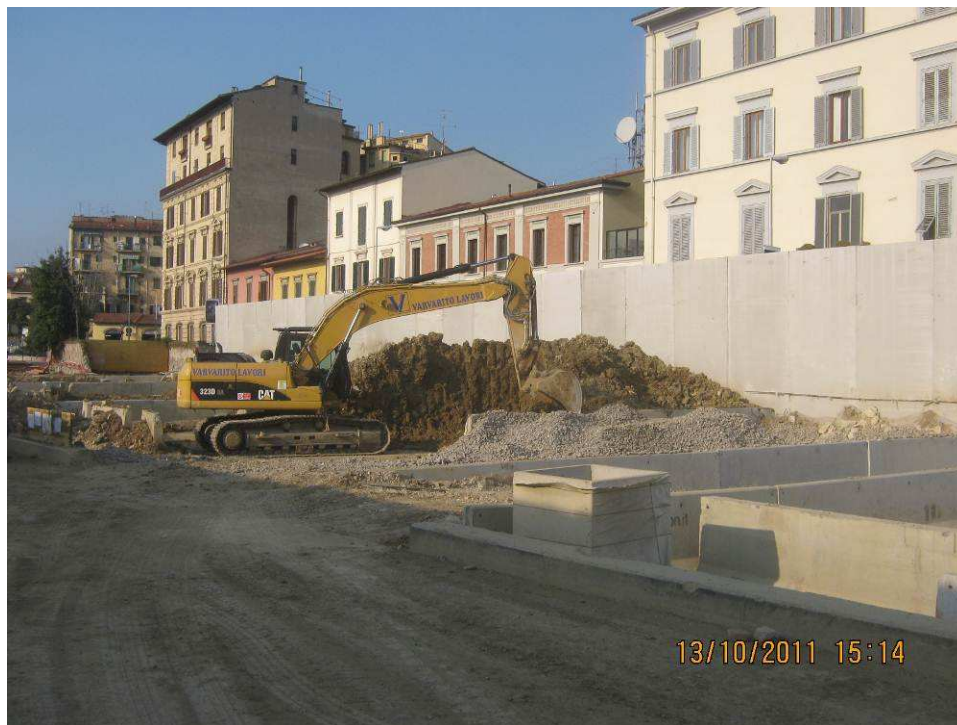
FOTO 5 – Movimentazione delle terre di scavo per la caratterizzazione
