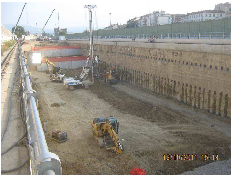
FOTO 1 – Pozzo Lancio Frese – consolidamento mediante pali Trelicon
