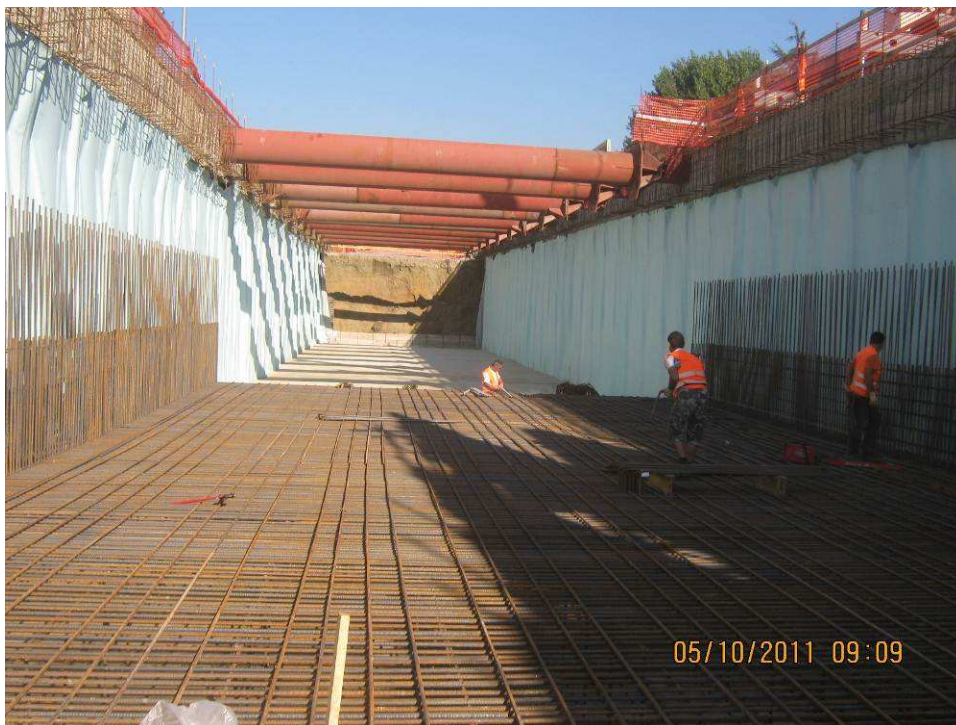
FOTO 3 – Continua la realizzazione della struttura interna in c.a. della Trincea
