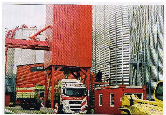
Bild 1: In Deutschland mangelt es nicht mehr an Herstellern von Holzpellets
