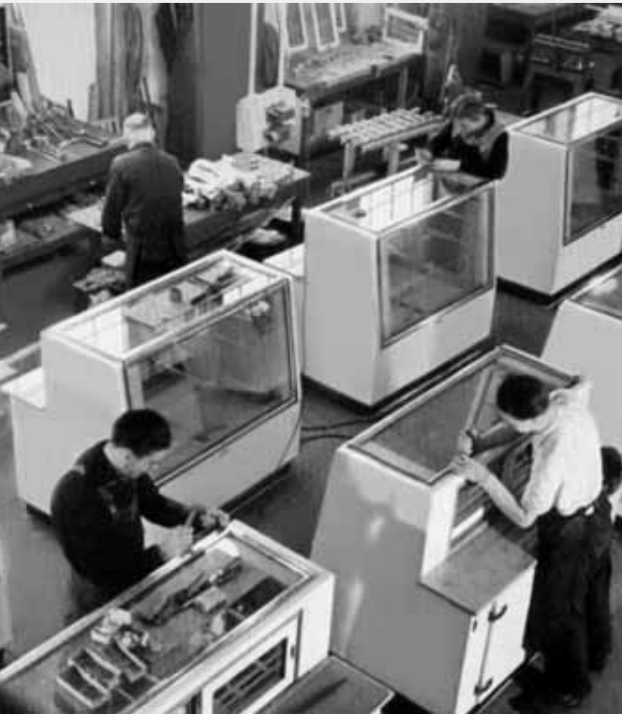
Bau von Kühlvitrienen im Kühlmöbelwerk Mainz-Kostheim (um 1950).
