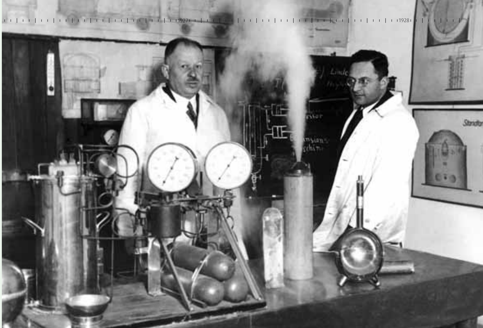
Paulus Heylandt (links) in seinem Berliner Labor, ca. 1935. Vorne rechts das Schnittmodell eines vom ihm entwickelten Transportgefäßes für flüssige Luft.
