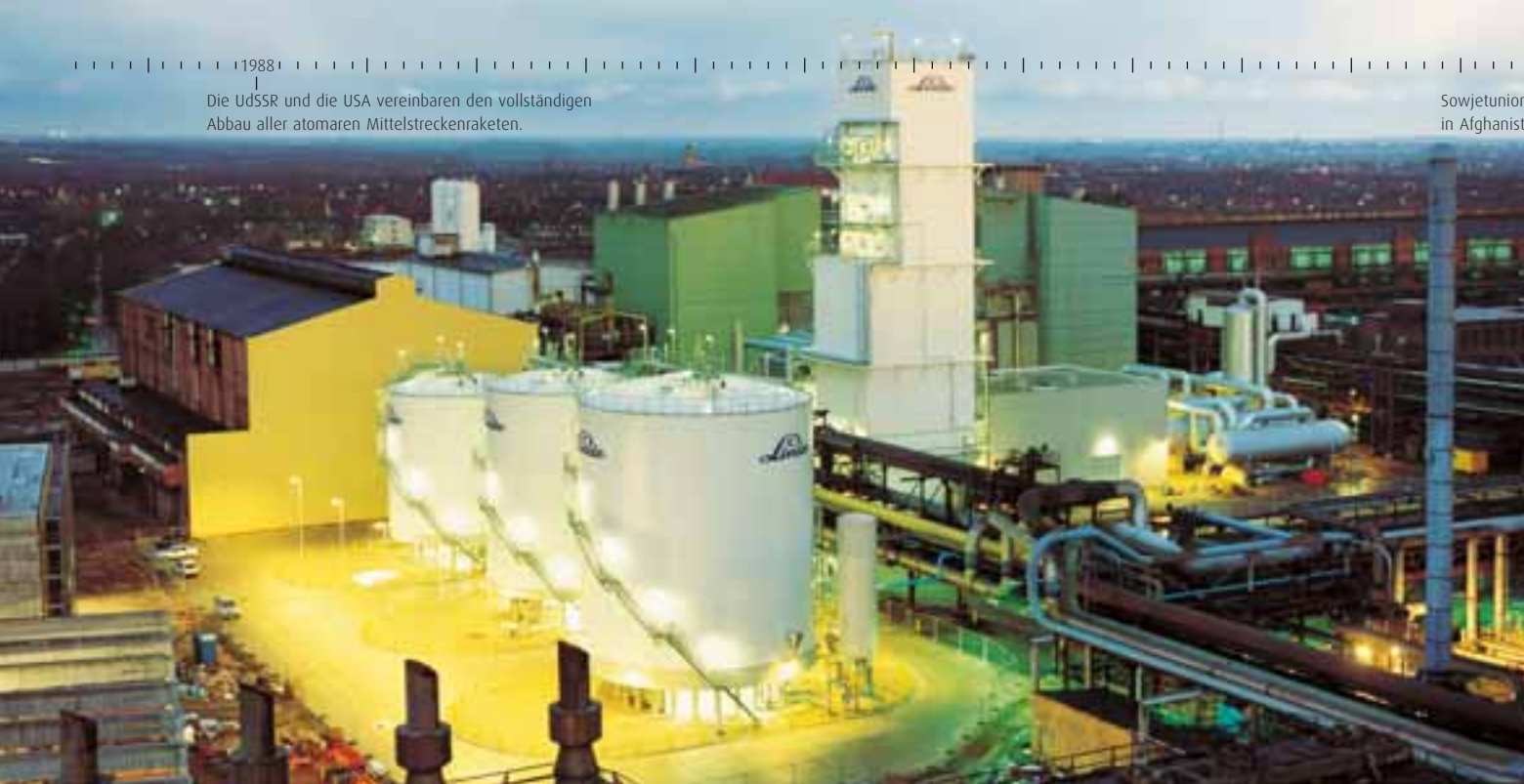
1994 eröffnete Linde in Leuna (bei Leipzig) eines der größten Gasezentren Europas.
