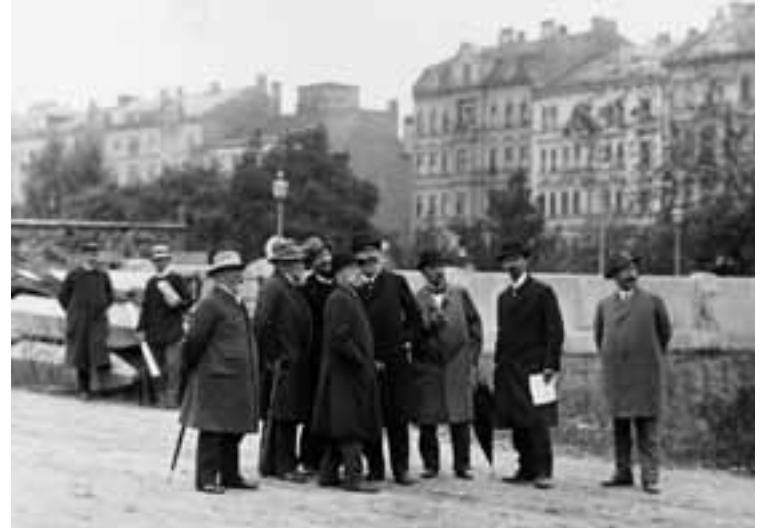
Carl von Linde (vorne links) begutachtet das Baugelände des Deutschen Museums in München gemeinsam mit den Architekten und den Herren des Bauausschusses (um 1910).
