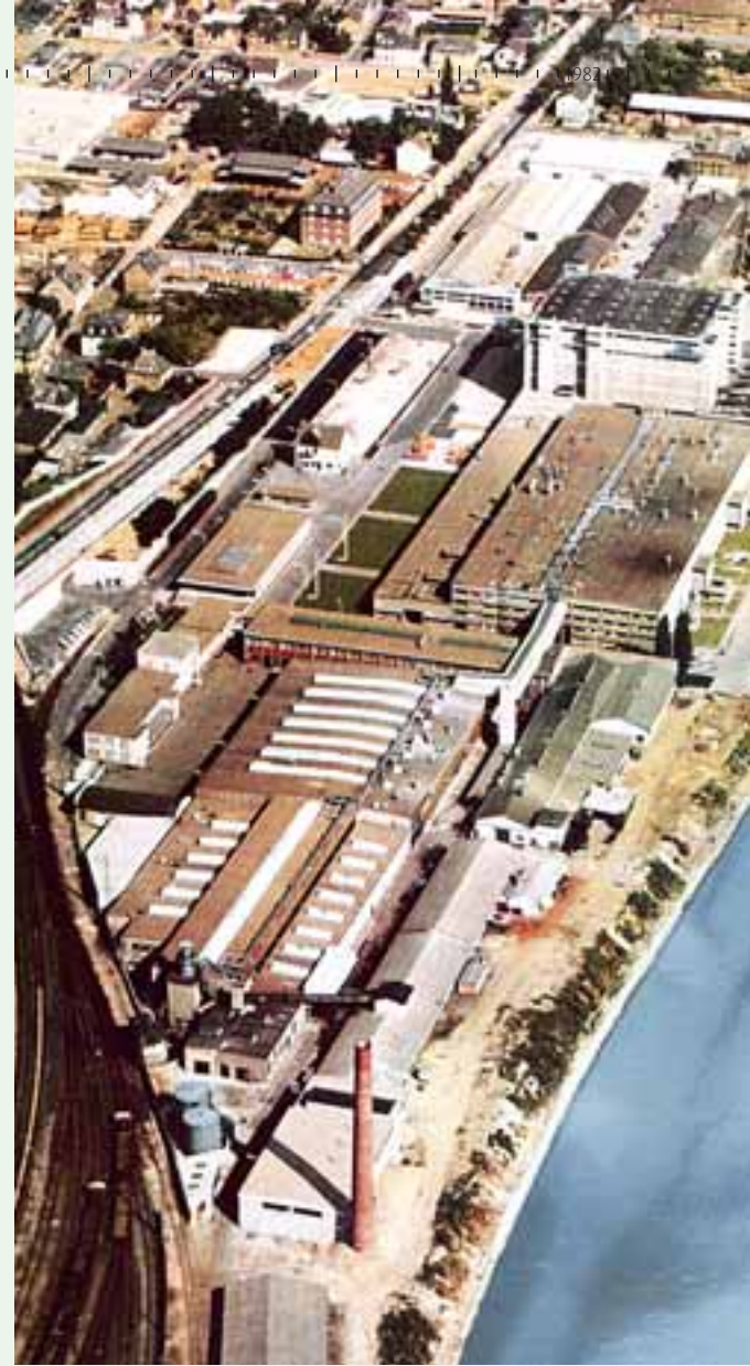
Das Kühlmöbelwerk in Mainz-Kostheim in den 1960er Jahren.
