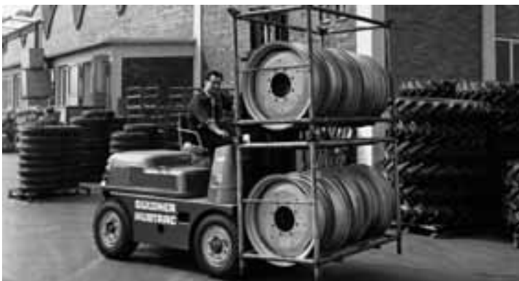
Der so genannte Hubtrac war der erste Linde-Gabelstapler; er wurde von 1959 bis 1969 gebaut.
