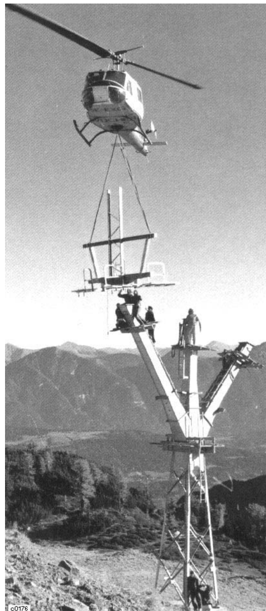
Stützenmontage mit dem Hubschrauber
