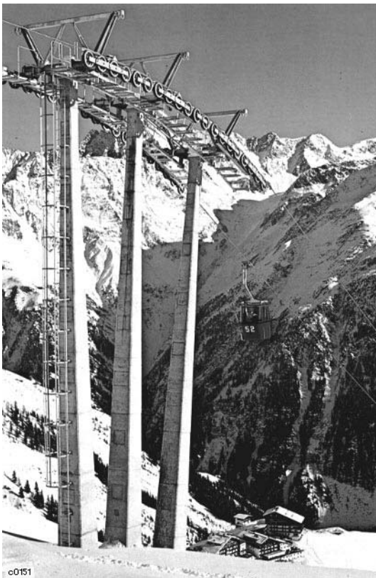
Dreifach-Betonstütze
