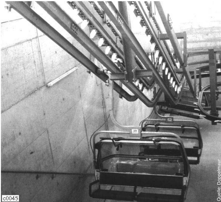
Hängeschiene und Mitnehmerkette als Fördereinrichtung zum Abstellbahnhof im Keller der Station
