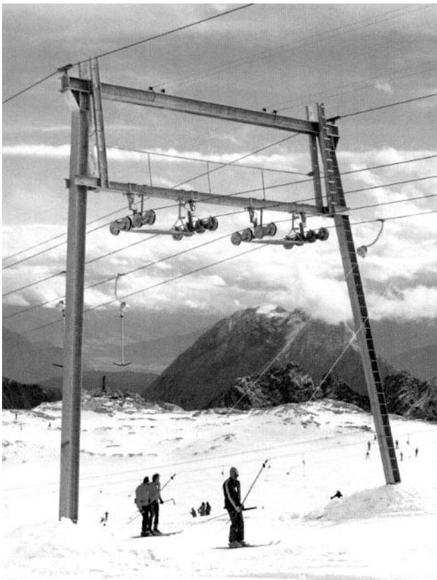
c0162 Quelle: Heuss Doppel Portalstütze eines Gletscher-Schleppliftes (Zugspitze)
