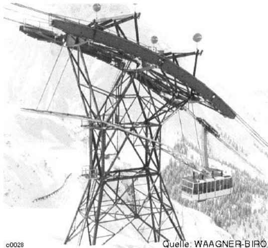
Fachwerkstütze einer Großkabinen-Pendelbahn (100-Personen-Kabine, Rüfikopf, Lech am Arlberg)
