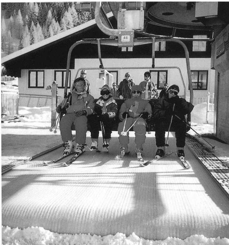
Förderbandeinstieg einer fest geklemmten 4er-Sesselbahn
