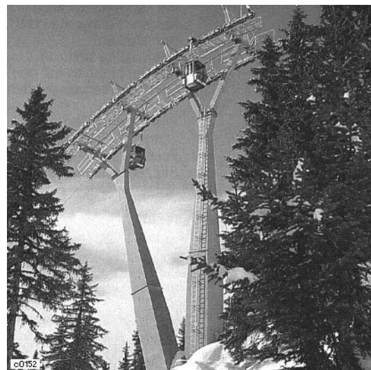
Doppel-Blechkastenstütze in Y-Ausführung
