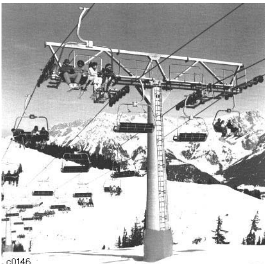
Rundrohrstütze
