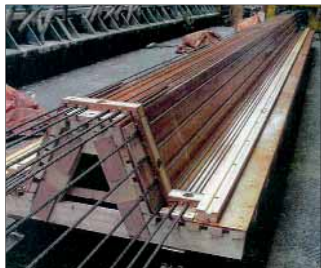
Abb. 14: Schalung für eine vorgespannte Spundwand aus hochfestem selbstverdichtendem Faserbeton
