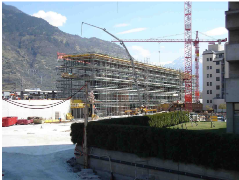
Der Neubau Bahnhof Visp: ein Gemeinschaftswerk
