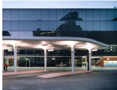
Der Neubau Bahnhof Visp: ein Gemeinschaftswerk
