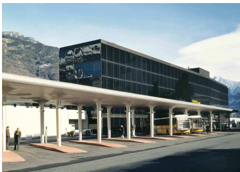
Der Neubau Bahnhof Visp: ein Gemeinschaftswerk
