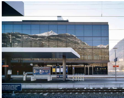
Der Neubau Bahnhof Visp: ein Gemeinschaftswerk
