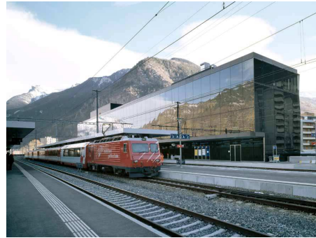
Der Neubau Bahnhof Visp: ein Gemeinschaftswerk
