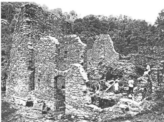
Fronarbeit an der ausgegrabenen und in Restauration begriffenen Verhüttungsanlage zuhinterst im Valle Morobbia, Tessin. (Foto aus Minaria Helvetica Nr. 19b, 1999)
