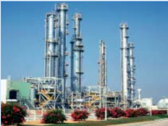
Abb. 6: Erdgasaufbereitung und C 2 Abtrennung
