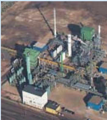
Unten Abb. 12: Bild einer kryogenen O 2 -Anlage für 1.500 Nm 3 /h Sauerstoff
