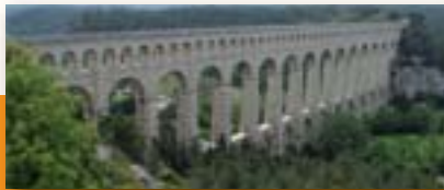
Canal de Marseille : aqueduc de Roquefavour
