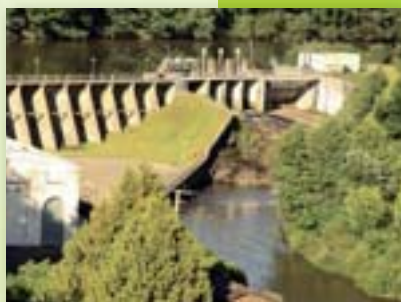
Aperçu du barrage de Vezens (I. Girardeau)
