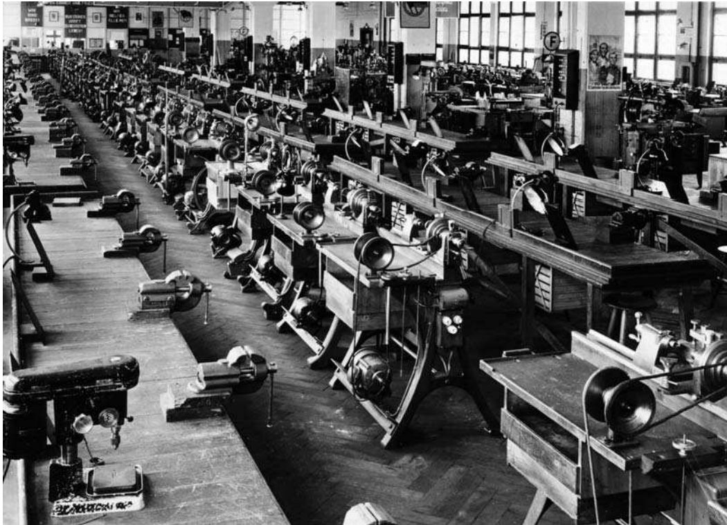
Carl Zeiss - Südwerk, Werkbanksaal der Lehrwerkstatt
