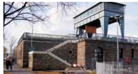
Staustufe Koblenz: Fußgänger – auf unbestimmte Zeit gesperrt
