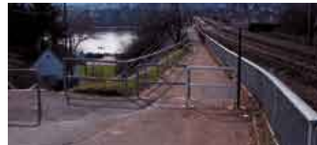
Gülser Brücke: Eisenbahn und Fußgänger
