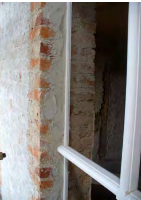
Sanierter Leibung mit Unterputz
