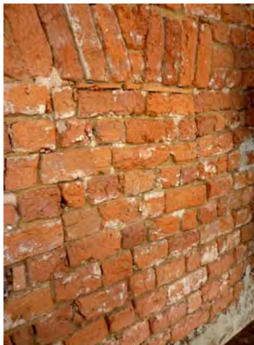
▲ Alte Fenster- vermauerung
