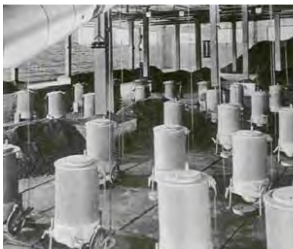
◀ Arbeitsplatz des Brenners auf dem Ringofen – Blick auf die Schürapparate
