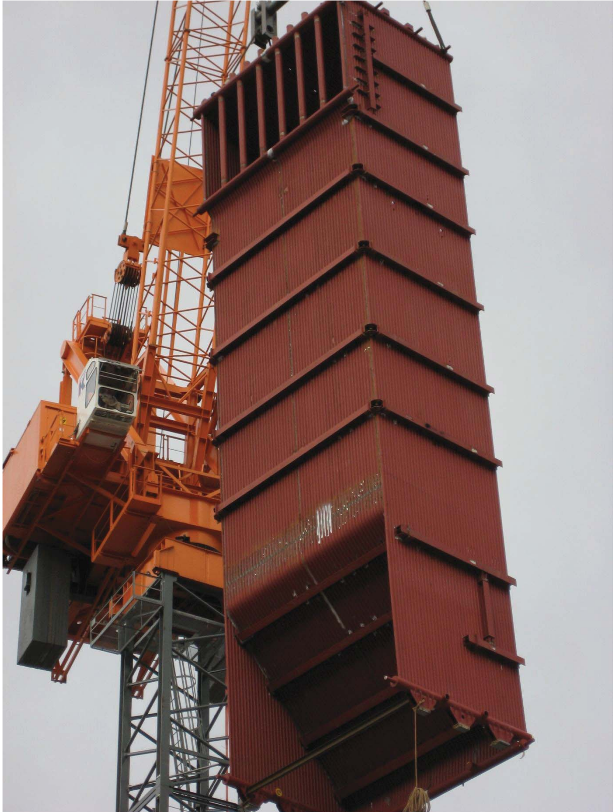
Abbildung 8 Erster Kesselzug eines Wasserrohrkessel für 44 t/h Dampfleistung
