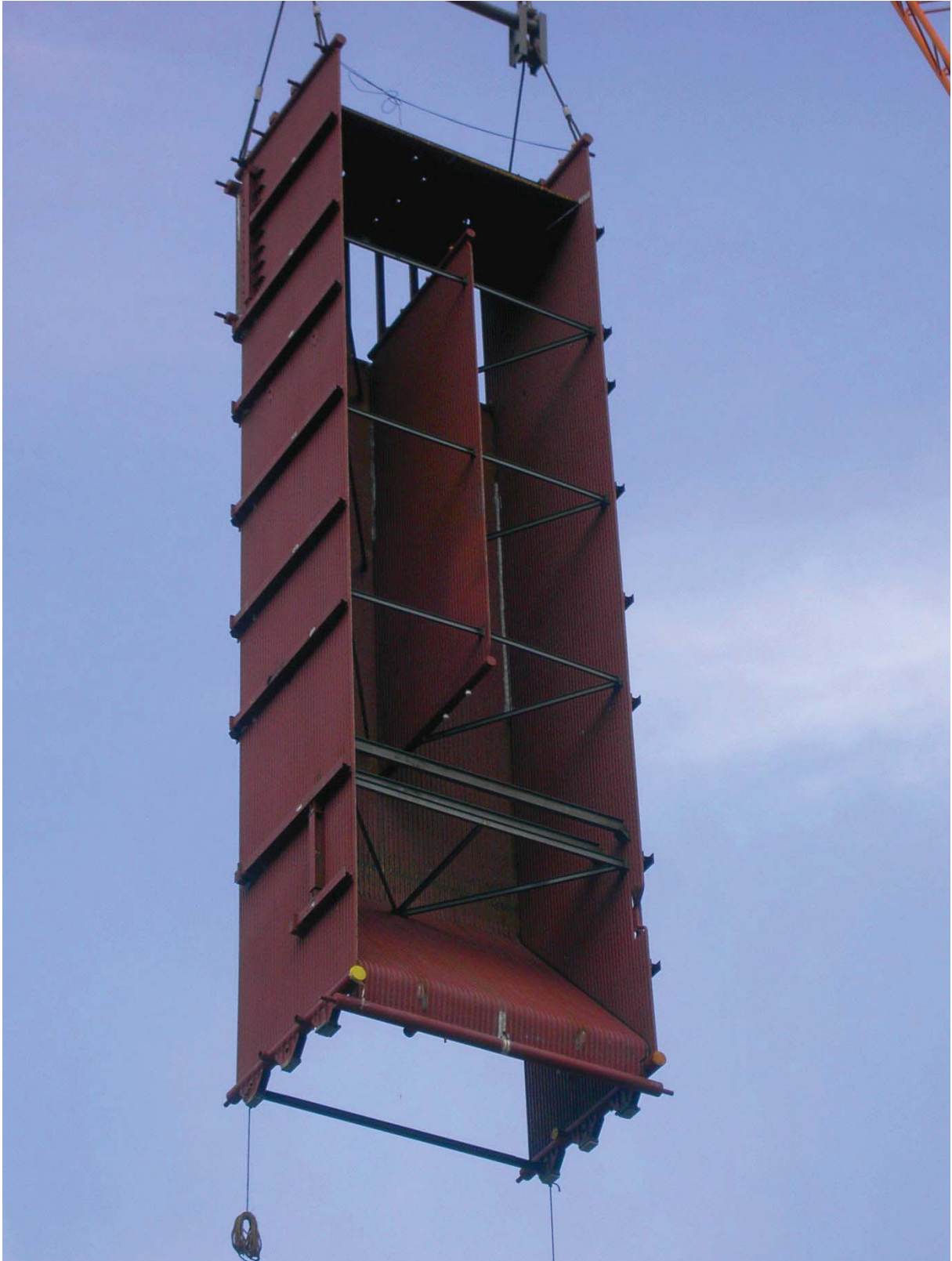
Abbildung 16 Strahlungszug des Kessels von Block III des Holzkraftwerks in Domat/Ems. Höhe der Seitenwand: 18.5 m.
