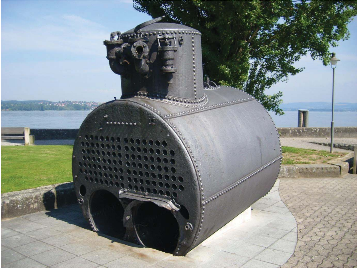
Abbildung 4 Flammrohr-Rauchrohrkessel des Raddampfers Rheinfall in Berlingen am Bodensee.
