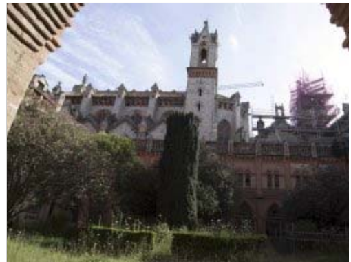
Las obras de rehabilitación del Seminario Mayor de la Universidad Pontificia de Comillas. / CELEDONIO
