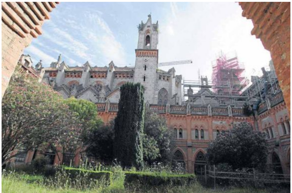
Las obras de rehabilitación del Seminario Mayor de la Universidad Pontificia de Comillas. / CELEDONIO
