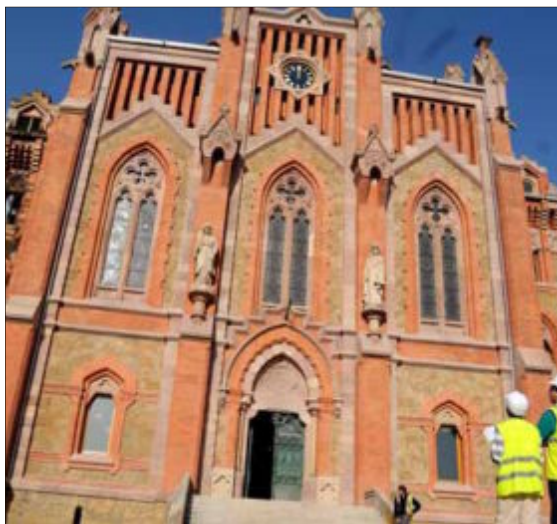
La fachada principal ha sido uno de los trabajos más complejos.
