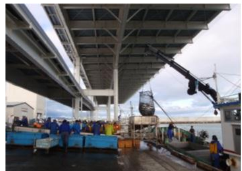
【衛生管理強化のため屋根付き岸壁を整備した漁港】
