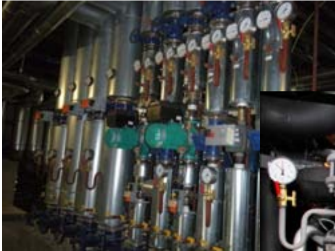
Heizungsverteiler
