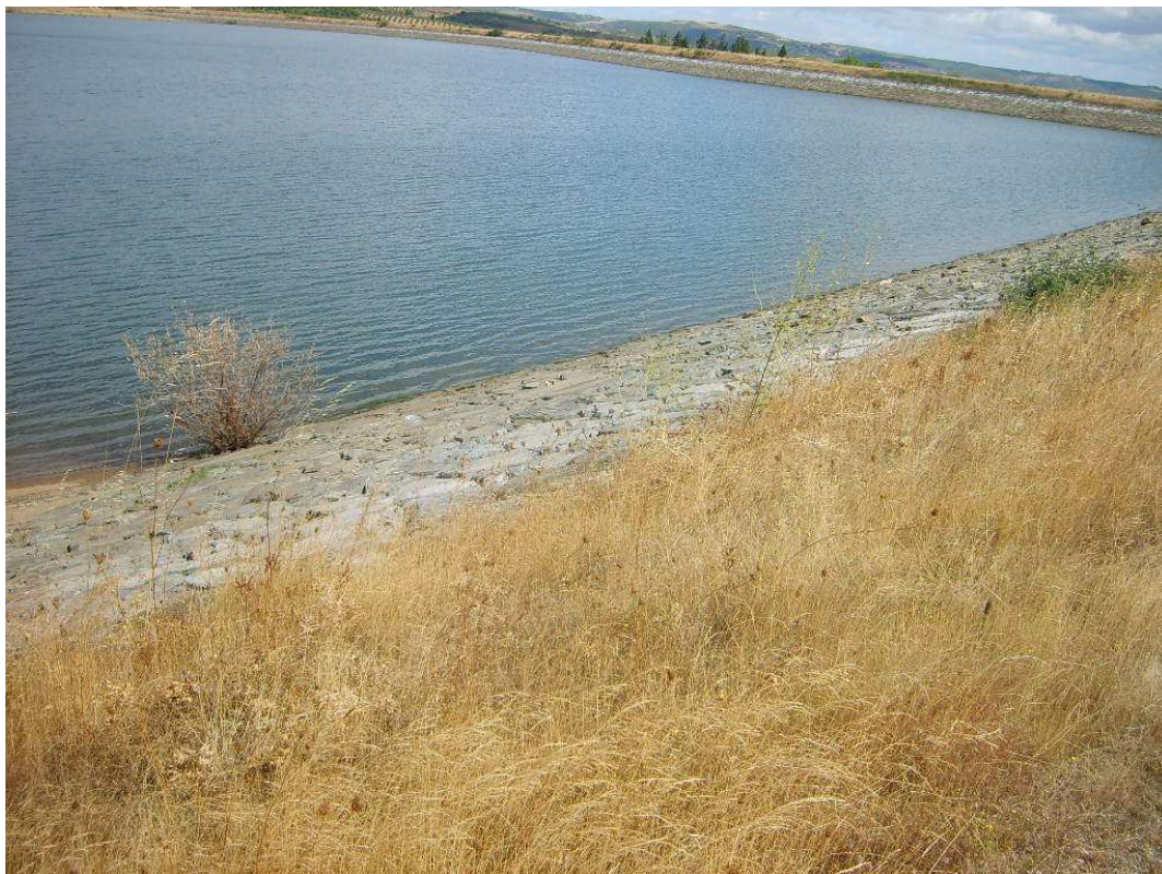
PARAMENTO DE MONTANTE
