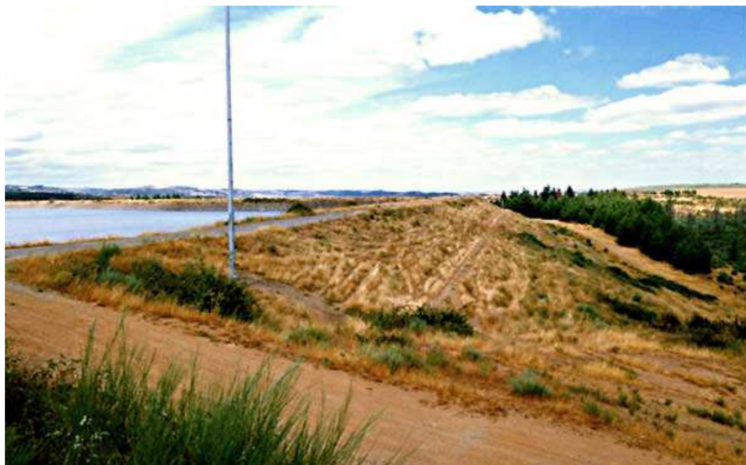
PARAMENTO DE JUSANTE
