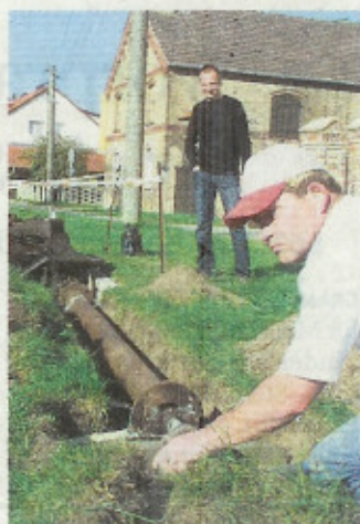
Die Montagearbeiten dauern an.
