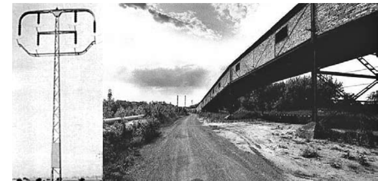
110 kV-Mast in Lauchhammer, um 1950 Brikettbandstraße zur Kokerei, 1953 Innenraum der Bandstraße, 1953
