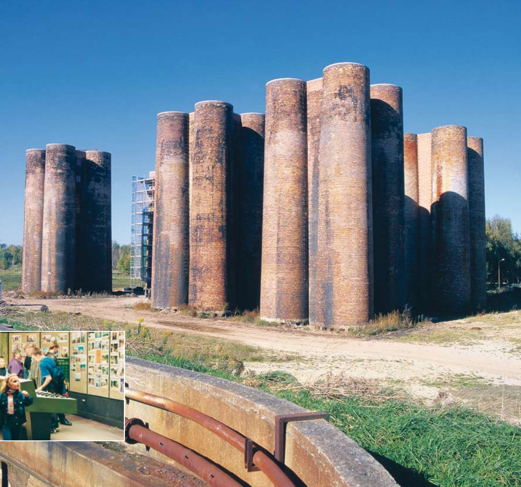
Sanierte Biotürme in Lauchhammer, 2007
