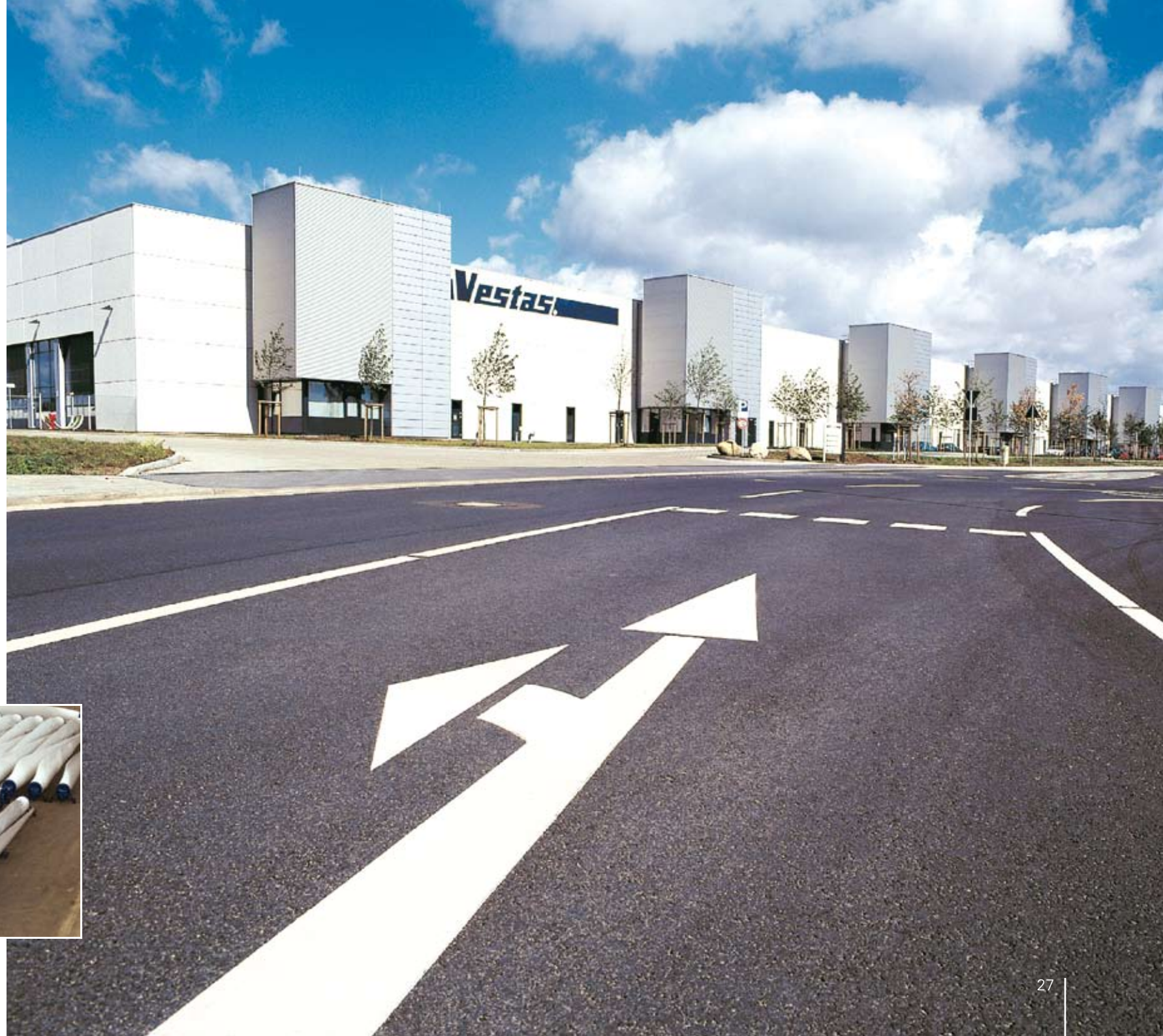
Rotorwerk der Vestas Blades Deutschland GmbH in Lauchhammer, 2002
