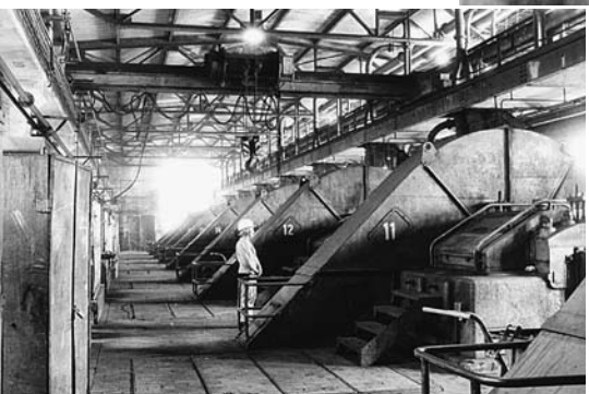
Pressenhaus der Brikettfabrik 64, um 1960
