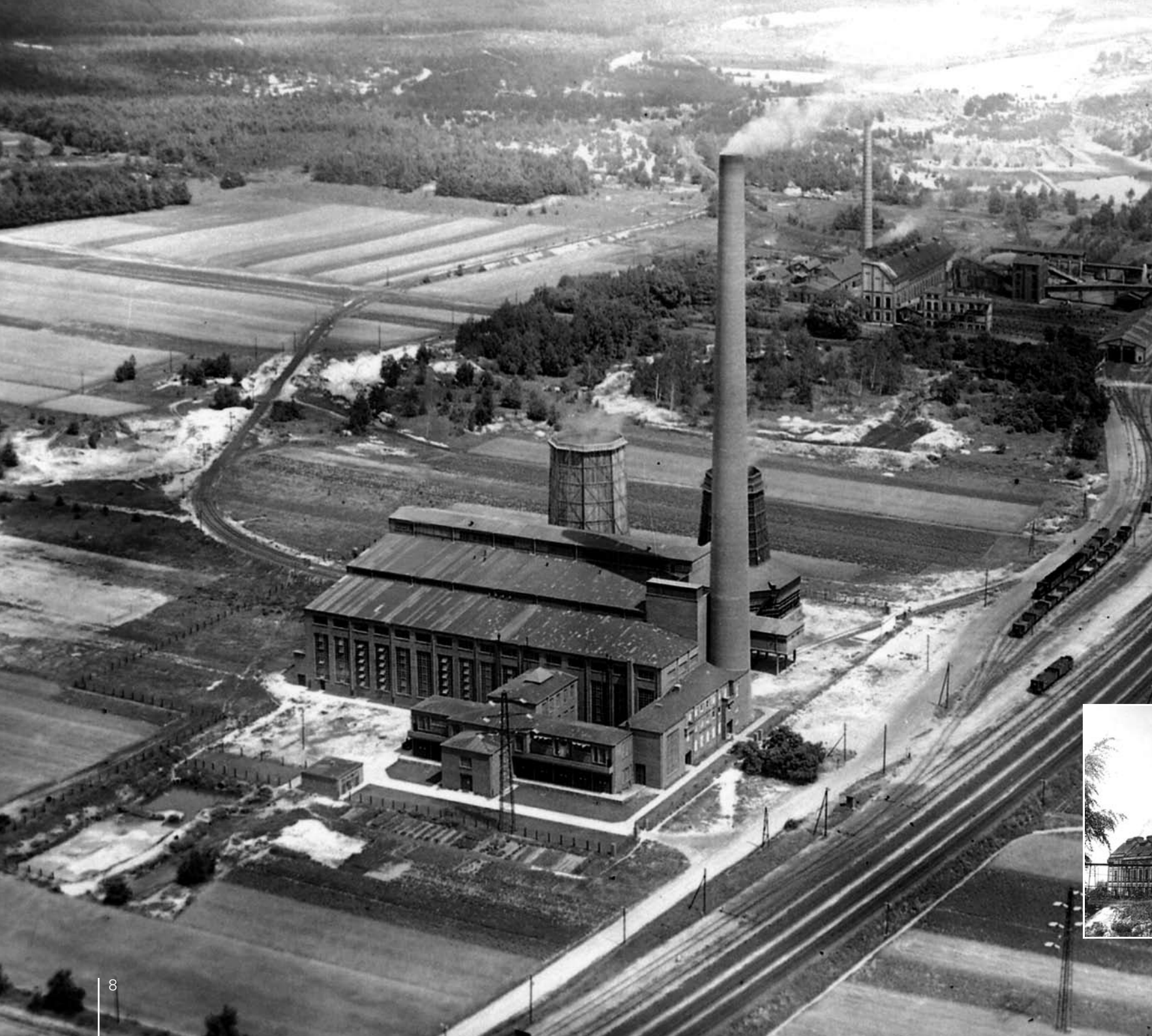
Luftaufnahme Kraftwerk und Brikettfabrik Plessa, um 1930
