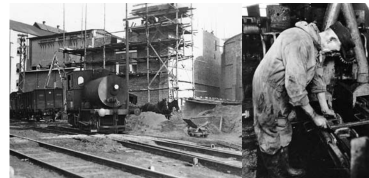
Neubau des Turbinenhauses an der Brikettfabrik Emanuel, 1926 Arbeiter an der Brikettpresse, um 1955
