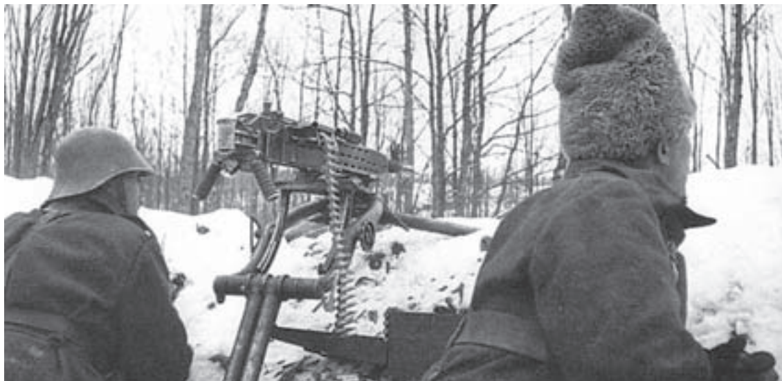
Mitraliera „ZB-53”, model 1937, calibru 7,92 mm
