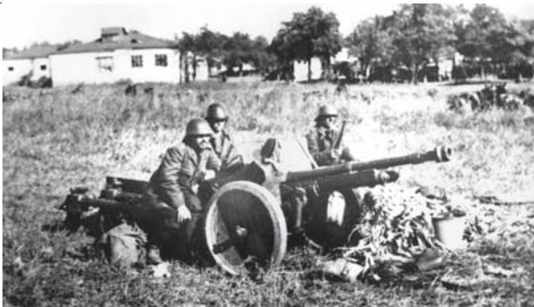
Tun antitanc „Schneider” model 1936, calibrul 47 mm, fabricat la Uzinele Astra
