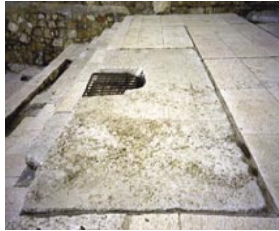
Abb. 35 Der größte Pflasterstein vor der Schönen Pforte (11m 2 )
