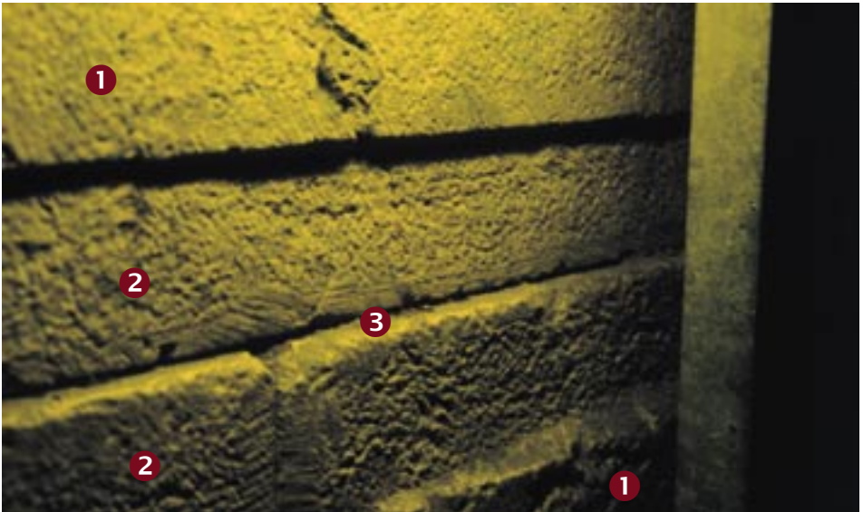
Abb. 157 Im Westmauer-Tunnel: Die erste und die zweite Bausteinlage. Der zweite Baustein wurde um ca. 2 cm zurückgezogen, um die Mauer leicht schief zu bauen, damit sie dem Beobachter auf der an ihr entlanglaufenden Straße in der beruhigenden Illusion gerade erscheinen sollte.
