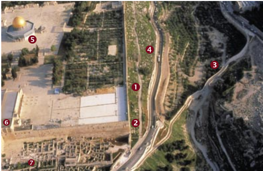
Abb. 21 Der Richtungs-Knick in der Ostmauer bezeichnet noch heute den Punkt, von wo ab die Makkabäer den Tempelplatz nach Süden (im Bild: unten) erweiterten. Die Distanz von der Südost-Ecke bis zum Knick beträgt ca. 73 m. 90
