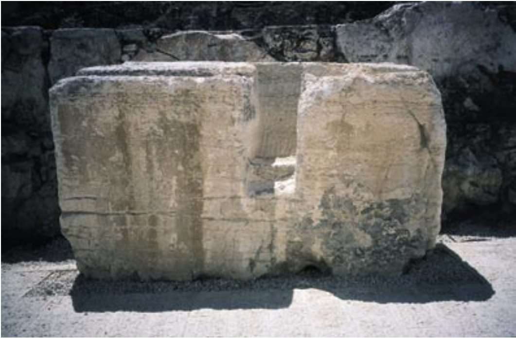
Abb. 160 Unvollendet gebliebenes Baumaterial. In den vorbereiteten Zwischenraum sollten Holzbalken eingelegt werden, die nach Übergießung mit Wasser eine Sprengung auslösen sollte, sodass aus diesem Felsblock zwei Bausteine hätten entstehen sollen.
