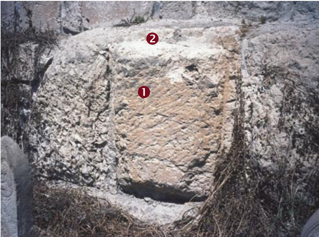
Abb. 55 Tempelbaustein aus der persischen Zeit in unmittelbarer Nähe zum Goldenen Tor (5. Jh. v. Chr.). 8 Anhand der Ausformung von Randschlag und Spiegel können Bausteine in Jerusalem zeitlich eingeordnet und bestimmt werden. 9
