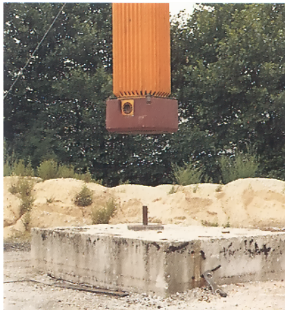
Fall auf einen Stahldorn
