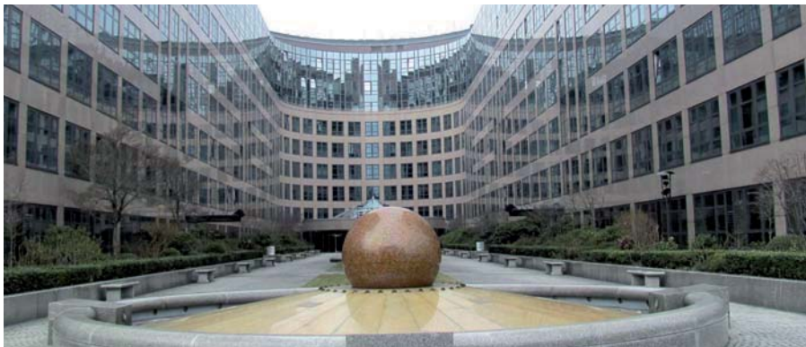
Das Bundesinnenministerium - der Neubau wird immer teurer.
