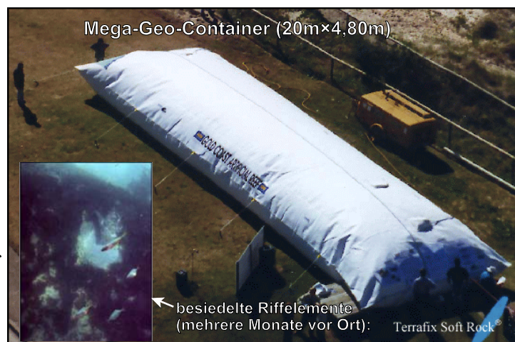
Abb. 1: Riffelemente aus Geotextilen Sandcontainern (QUIRK et al.; 2001)
