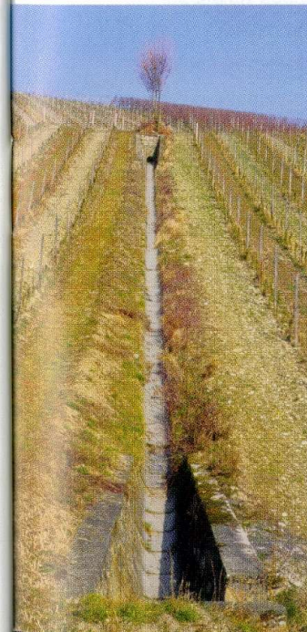
Rebhänge gehören zu den stark erosionsgefährdeten Standorten. Die Einrichtung von Absatzbecken am Hangfuß kann zumindest einen Teil des erodierten Bodens zurückhalten
