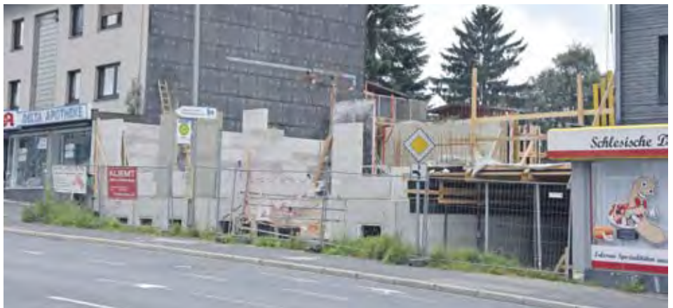
Ein Wohn- und Geschäftshaus entsteht an der Barmer Straße.
