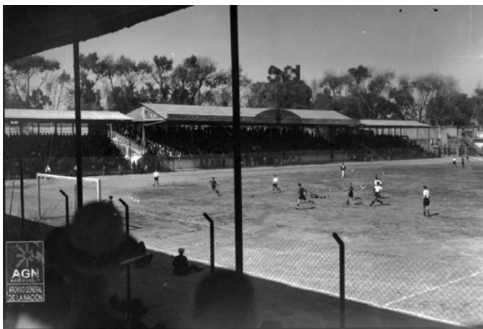
Vista del parque España. Inaugurado en 1915. Ubicado en la Calzada de la Verónica, hoy Melchor Ocampo.
