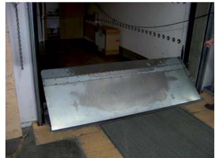
Ladebrücke an Koffer des Fahrzeuges anpassen
