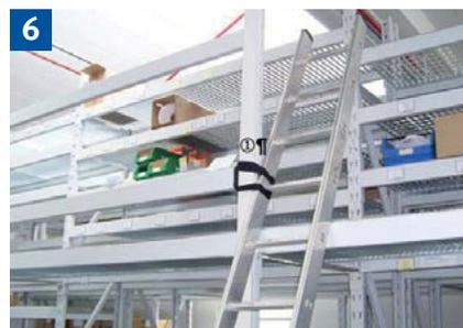
1 Sicherungsmöglichkeit durch Anbinden oder eine zweite Person.
