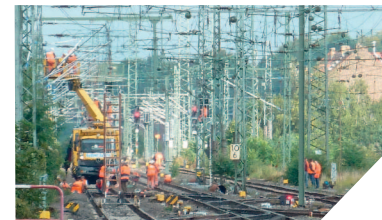
Bauarbeiten am Offenbacher Hauptbahnhof
