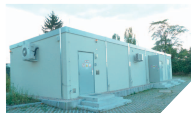
Das 6-modulige Gebäude von marbeton für das ESTW Offenbach Hauptbahnhof
