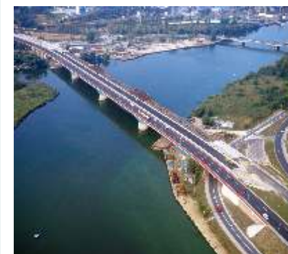
Foto 12: Brücke der Pioniere in Szczecin
