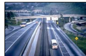
El Monte Busway, Los Angeles
