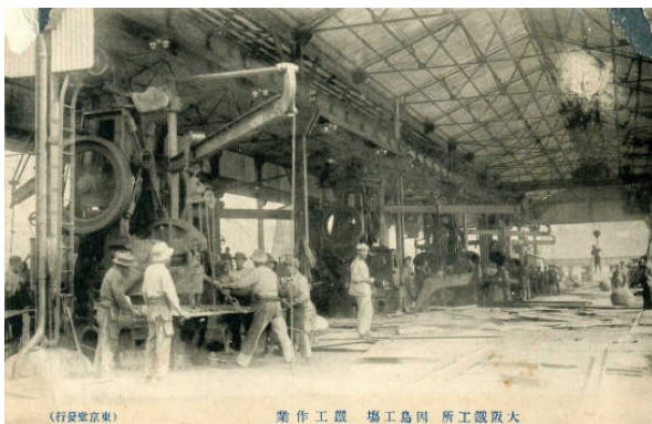
(行東館京東) 業作工鐵 場工島因 所工鐵阪大
