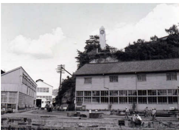
東工場名物の時計塔と木型工場（昭和24年）
