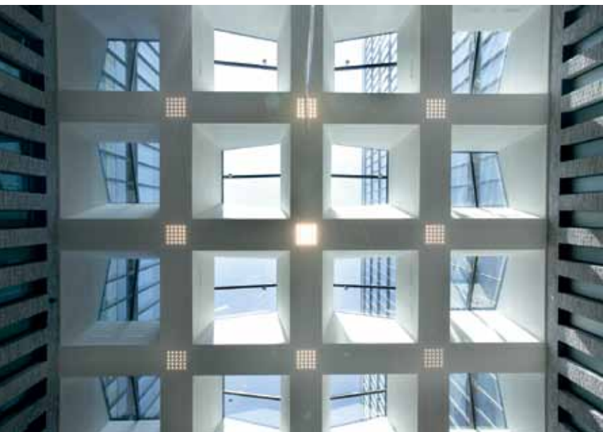
Glazen dak met cassetteplafond in het atrium
