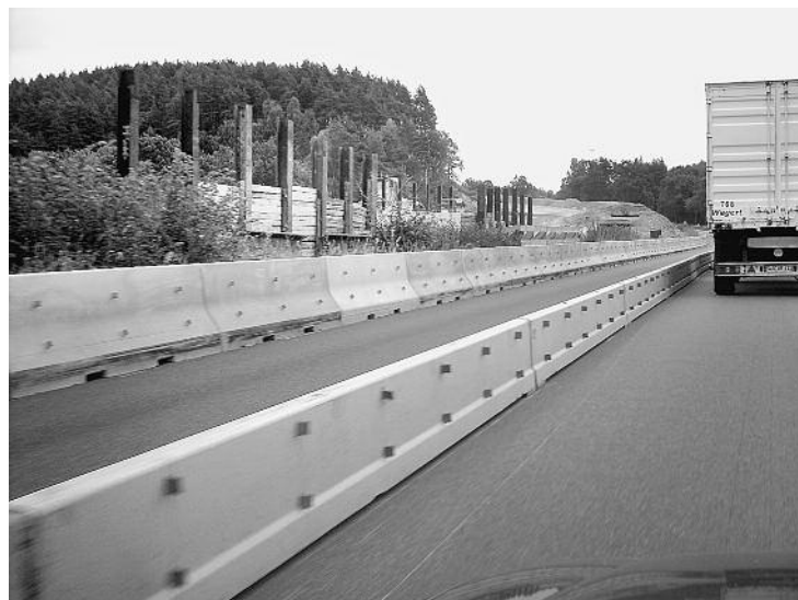
Abb. 128 | A 70 Bamberg-Bayreuth Fahrtrichtung Bayreuth, Trassierungsveränderung, 2013. Die neue Trasse liegt auf der Aufschüttung im Hintergrund, vgl. Abb. 113
