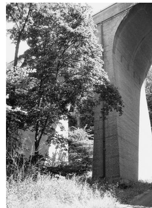
Abb. 131 | A8 Stuttgart-Ulm Alaufstieg, Malakoffbrücke, 2015 Fertigstellung 1950er Jahre, Beton, Oberfläche in Steinmetztechnik bearbeitet
