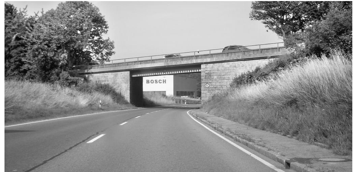
Abb. 136 | A8 Stuttgart-Ulm Alaufstieg, Unterführung der B 466 nördlich Mühlhausen, 2015 Beide Unterführungen liegen von der Bundesstraße gesehen aus kurz hintereinander im Bereich der beginnenden Fahrbahnteilung der Autobahn in Abstiegs- und Aufstiegsstrecke
