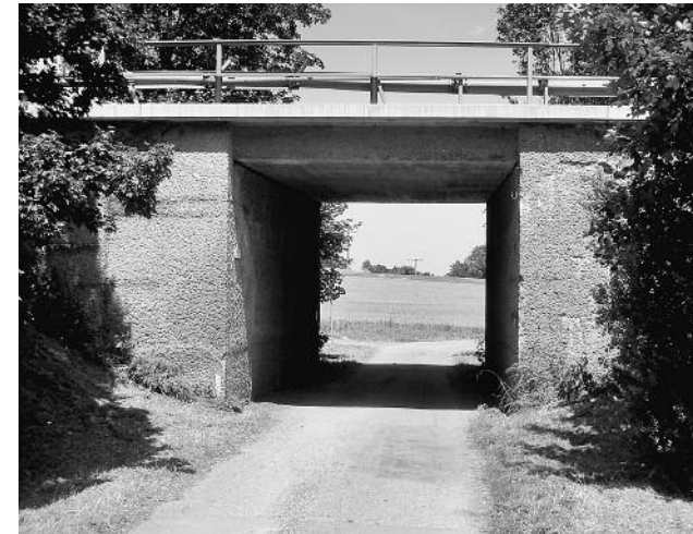
Abb. 134 | A8 Stuttgart-Ulm Alaufstieg, Wegunterführung oberhalb des Lämmerbuckeltunnels, 2015 Beton, Oberfläche in Steinmetztechnik bearbeitet
