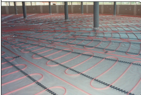
MB-Estrichsystem 17 nach der Verlegung
