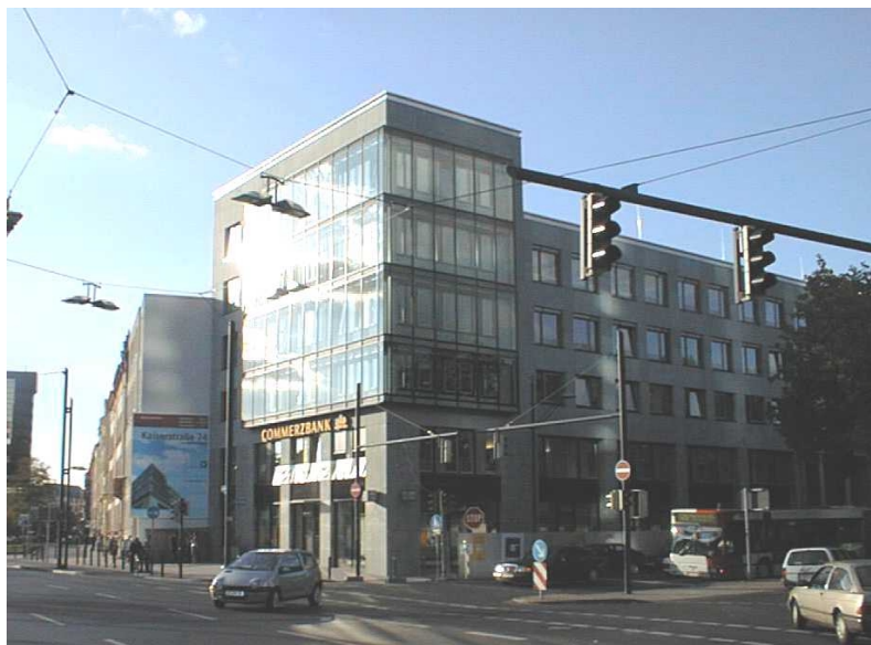
Abb. 4 Neubau der Commerzbank, Berliner Straße
