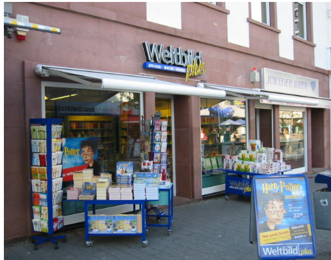
Abb. 12: Renovierte Fassade Frankfurter Straße
