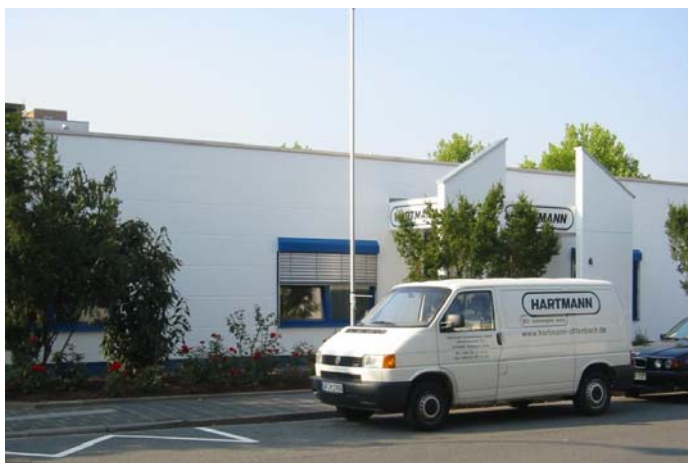
Abb. 10: Neuer Standort Hartmann Förderanlagen GmbH Quelle: Eigene Darstellung
