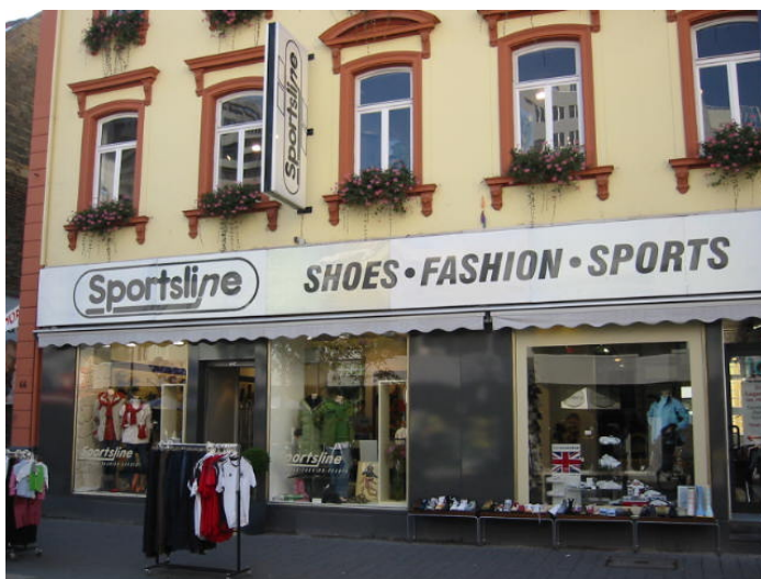
Abb. 13: Renovierte Fassade Frankfurter Straße
