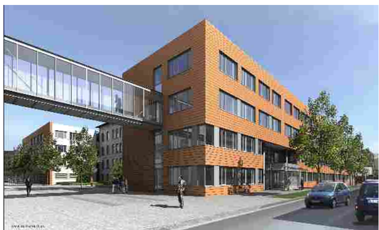
Abb. 5: Neues Justizzentrum, Investor: Internationales Immobilien Institut
