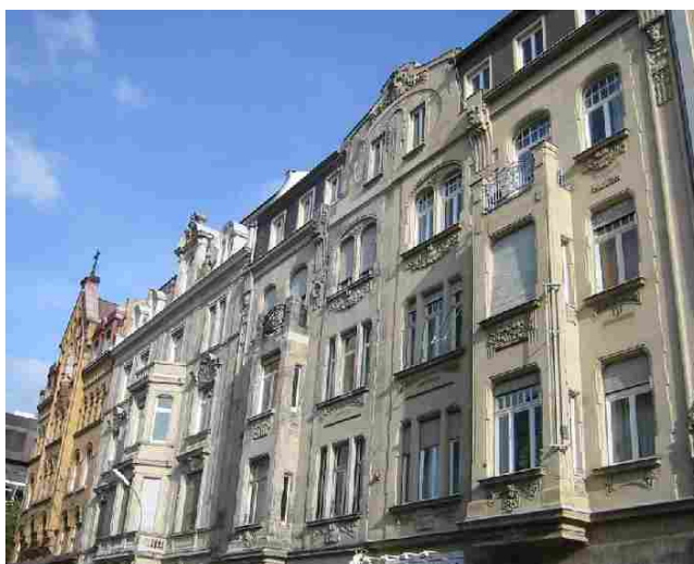
Abb. 15: Renovierte Fassade, Kaiserstraße 65
