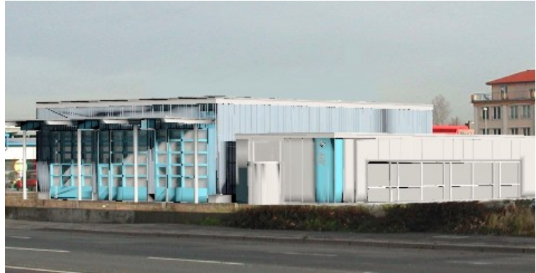
Abb. 8: Neuer Standort TÜV Hessen, derzeit in Bau, Rowentastraße
