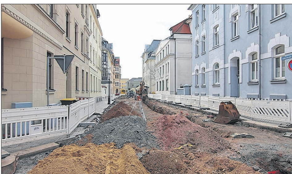
AUF DER LUTHERSTRASSE KOMMT ES DURCH DIE SANIERUNG ZU EINSCHRÄNKUNGEN FÜR DIE ANWOHNER. BIS ENDE AUGUST SOLLTEN DIE ARBEITEN BEENDET SEIN. FOTO: STADT ZWICKAU
