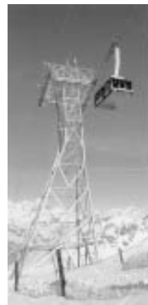
Pila en celosía del teleférico del Matterhorn. Fabricante: Garaventa.
