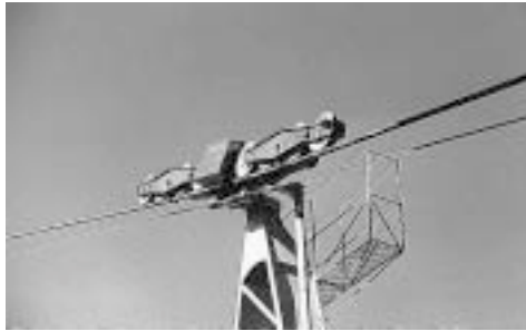
Carretón, cable portante y cable tractor en el teleférico del Teide. Foto: Alfonso Orro
