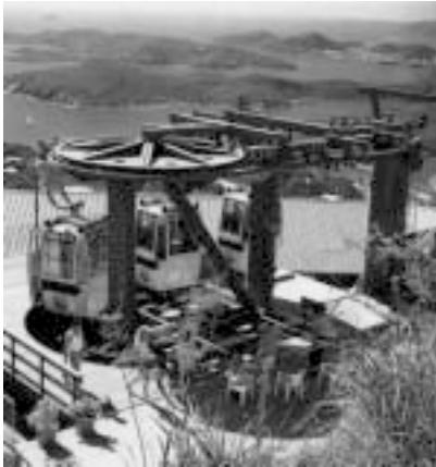
Sencillez de la estación superior del teleférico de las Islas Vírgenes. Fabricante: Doppelmayr
