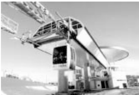
Telecabina de movimiento continuo, circulante, unidireccional no permanente. Fabricante: POMA
