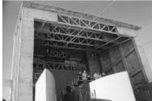
Estación superior del teleférico del Teide. Puede apreciarse el foso y la elevación sobre el terreno. Foto: Alfonso Orro
